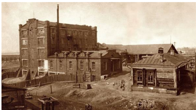
Лесопильный завод В. Л. Жернакова, 1914 г.
